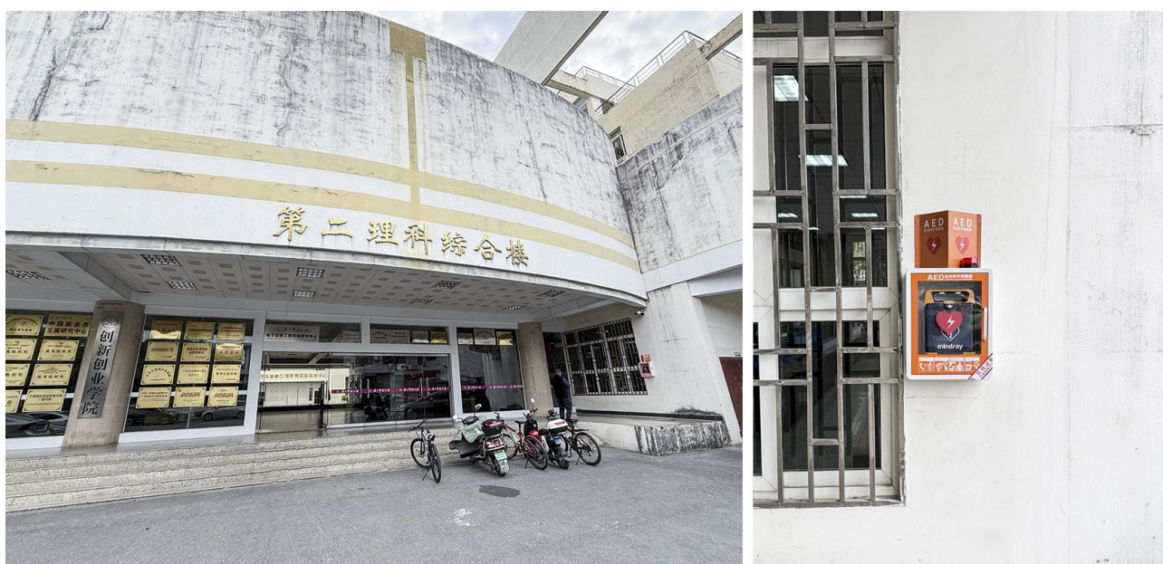
育才校区第二理科综合楼 AED 安装位置现场图
