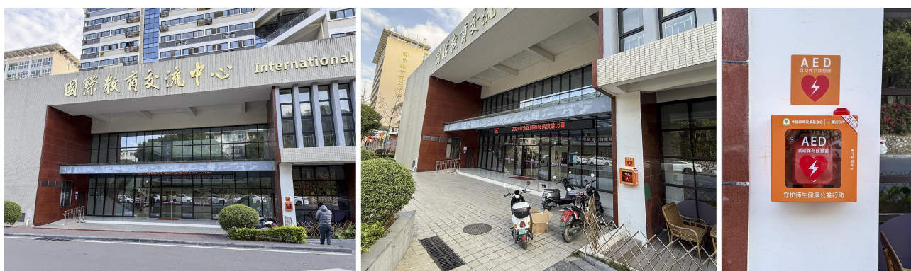
育才校区国际教育交流中心（2号楼）AED 安装位置现场图
